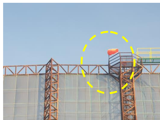
รูปที่ 44 ถังลมที่ติดตั้งไว้เพื่อตรวจสอบทิศทางลม
