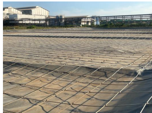
รูปที่ 28 บ่อกากส่าปิดคลุมด้วย HDPE และตาข่าย
