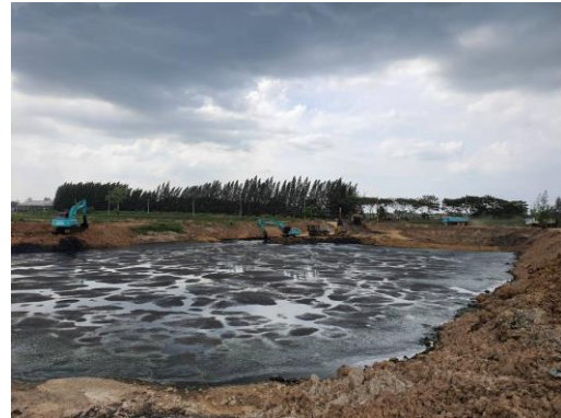
รูปที่ 25 การขุดลอกบ่อบำบัดน้ำเสีย
