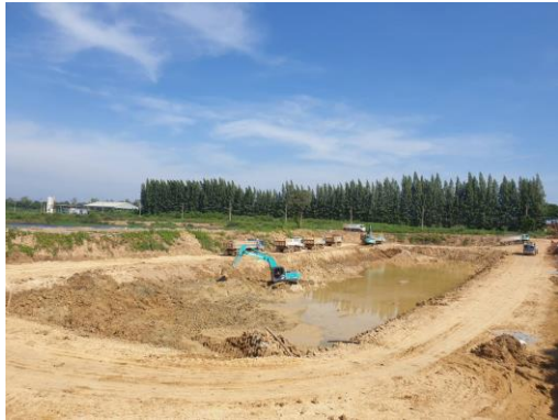
รูปที่ 25 การขุดลอกบ่อบำบัดน้ำเสีย
