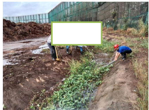
รูปที่ 20 เจ้าหน้าที่ตักเศษกากอ้อย/การขุดลอกรางระบายน้ำรอบลานกองเก็บกากอ้อย
