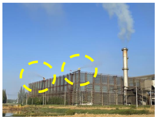
รูปที่ 18 การฉีดพรมบริเวณลานกองเก็บกากอ้อย
