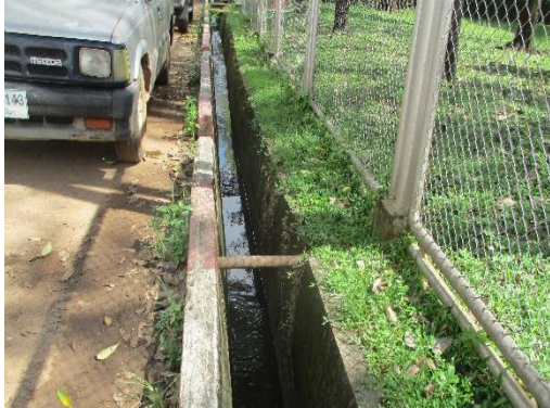
รูปที่ 76 ระบบรวบรวมน้ำฝน
