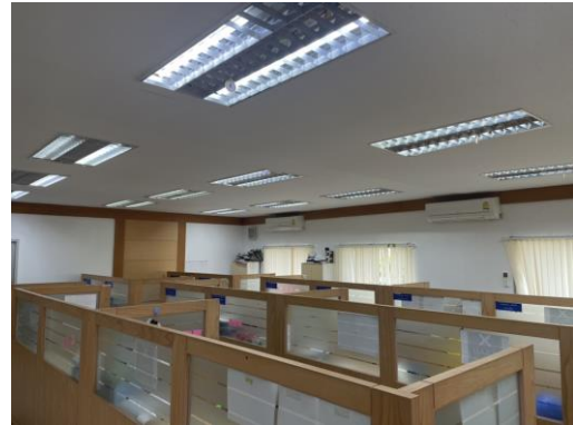
รูปที่ 98 การจัดตำแหน่งหลอดไฟให้ตรงโต๊ะทำงาน
