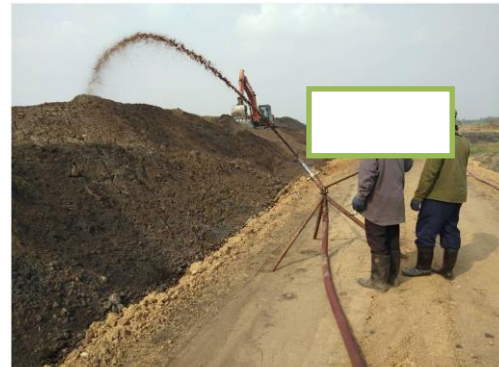
รูปที่ 27 การฉีดเชื้อจุลินทรีย์ดับกลิ่น บริเวณลานกองกากตะกอนหมักกรองและลานกองเถ้า
